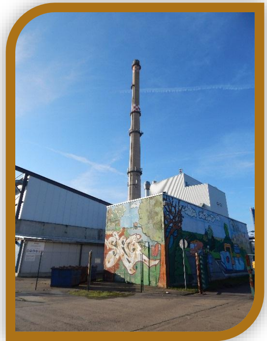
Planta de Incineração na Alemanha (acervo MMA)
